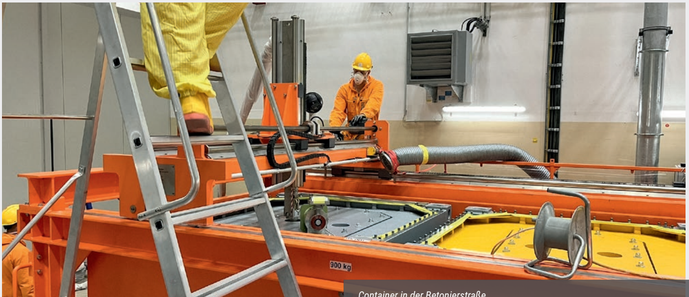
Container in der Betonierstraße.
