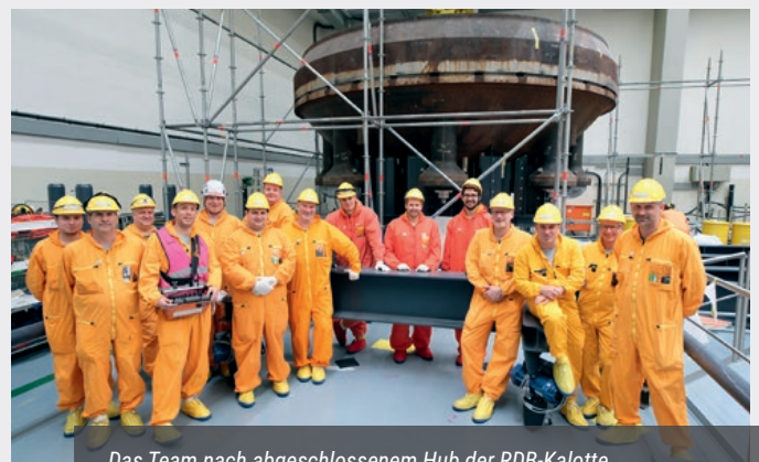
Das Team nach abgeschlossenem Hub der RDB-Kalotte.
