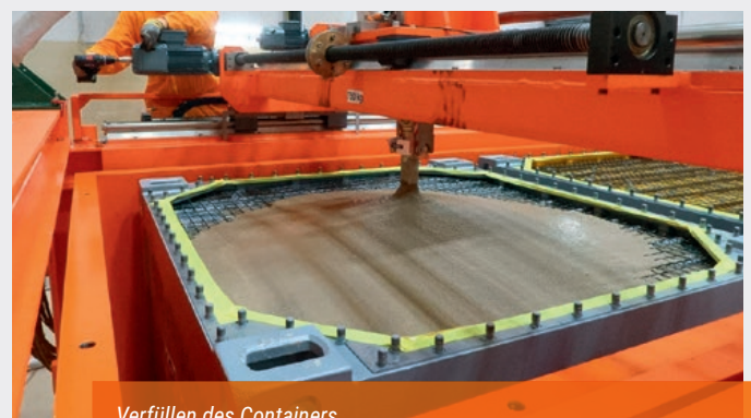
Verfüllen des Containers.
