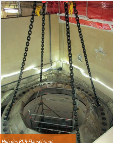
Hub des RDB-Flanschrings.
