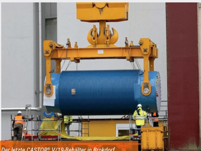
Der letzte CASTOR® V/19-Behälter in Brokdorf. Foto: PreussenElektra GmbH
