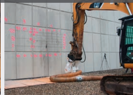
Detailansicht des Fräskopfs, Bagger mit montiertem Fräskopf vor dem Testfeld für Fräsversuche.
