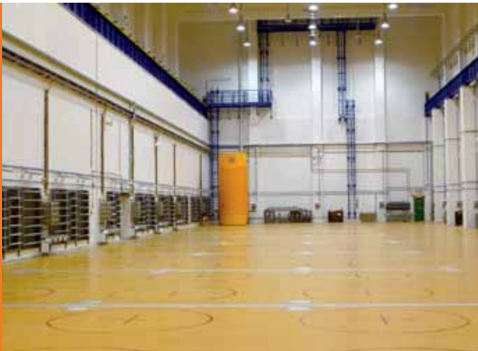
Erster im Behälterzwischenlager in Temelín eingelagerter Behälter
