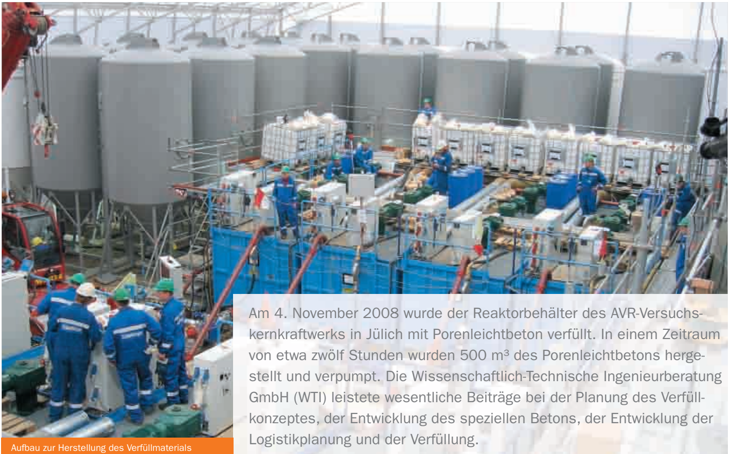
Aufbau zur Herstellung des Verfüllmaterials
