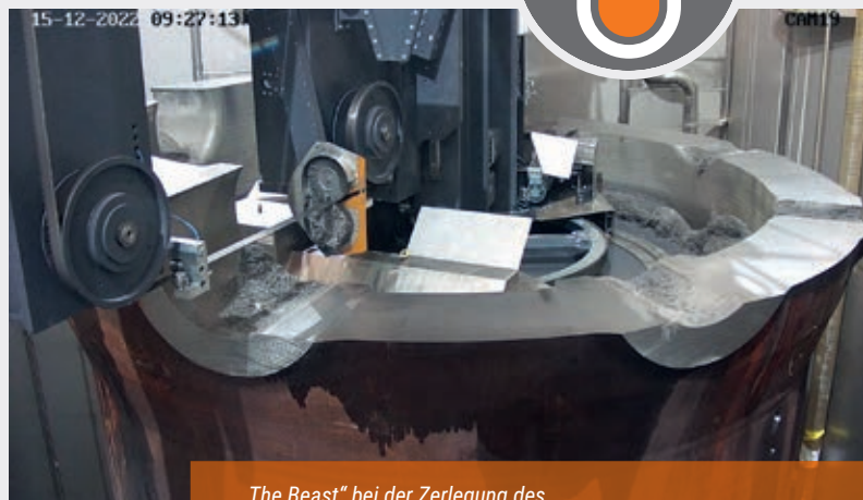
„The Beast“ bei der Zerlegung des RDB-Flanschbereichs im KKK.
