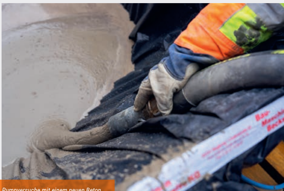
Pumpversuche mit einem neuen Beton.
