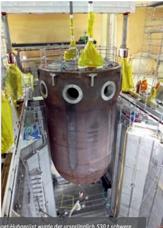
Mit dem Mammoet-Hubgerüst wurde der ursprünglich 530 t schwere RDB im KKK auf das Zerlege-Gestell für die Bodenkalotte umgesetzt.
