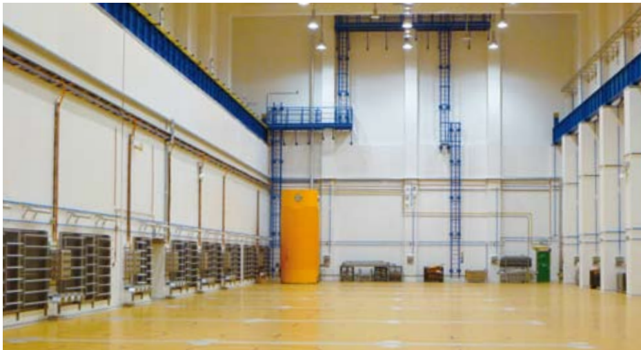
September 2010: Der erste CASTOR® 1000/19 im Zwischenlager.
