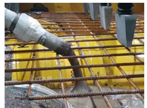
Betonierung mit Niederhalter.
