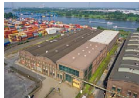
Luftbild der ehemaligen GNS-Betriebsstätte in Duisburg-Wanheim.
