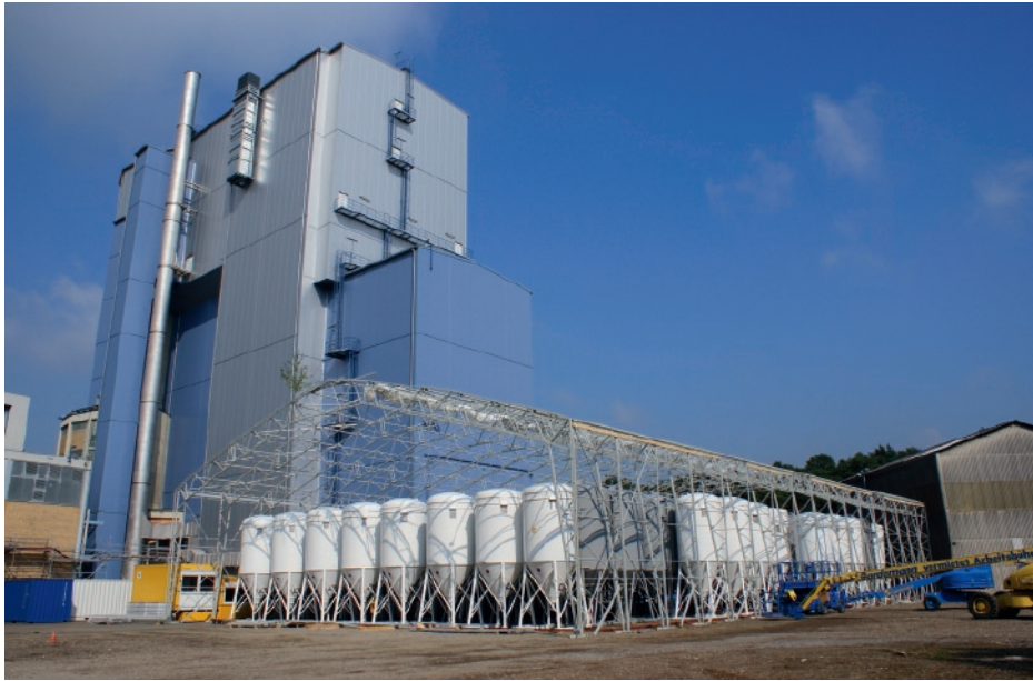
Vorlagebehälter zur Herstellung des Porenleichtbetons
