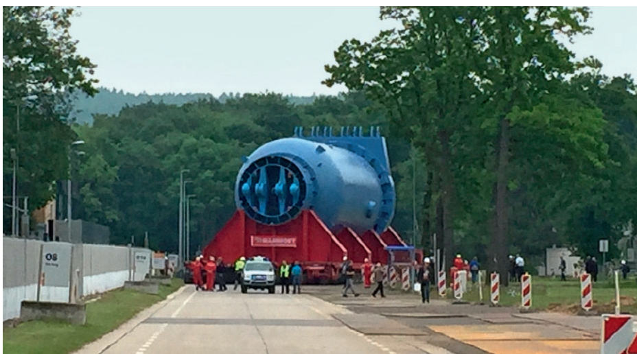
Abtransport des Reaktorbehälters im Mai 2015
