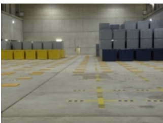
Westliche Hallenhälfte mit Abfallbehältern
